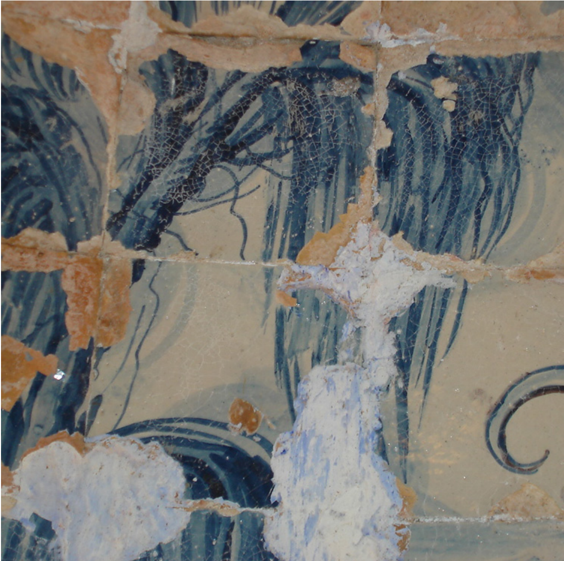
Figura 25- Tratamento das lacunas com gesso pintado de azul. As eflorescências que realçam, tanto as juntas, como o craquelé são presumivelmente desse gesso, constituindo um risco adicional.
