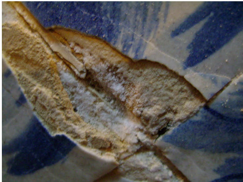
Figura 15- Processo de perda do vidro em curso, evidenciando o tamanho dos fragmentos
