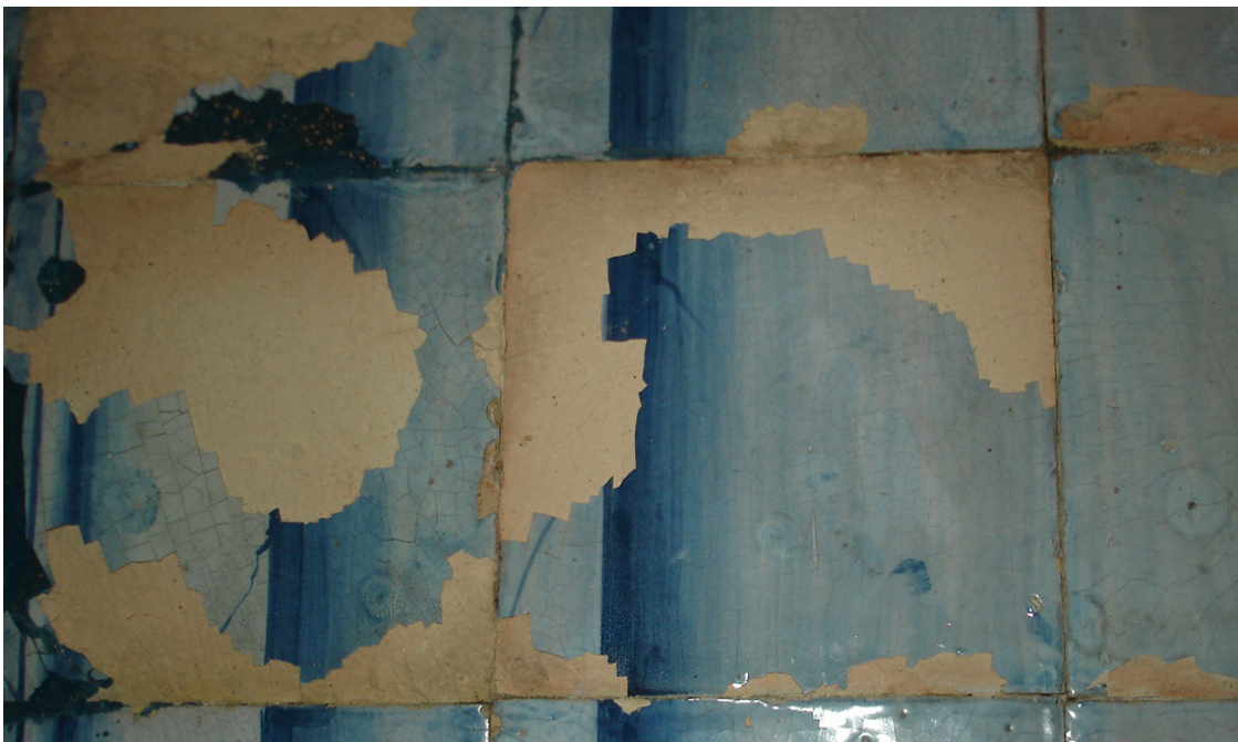
Figura 26- Azulejos com craquelé em processo de destacamento. O vidrado cai em mosaico, originando lacunas com fronteira poligonal. São também visíveis poros que, como no caso da figura 20, revelam marcas aureolares. Estas podem ser causadas pela penetração de lixívia de limpeza nos poros do vidrado ou serem indiciadoras de um processo evaporativo
