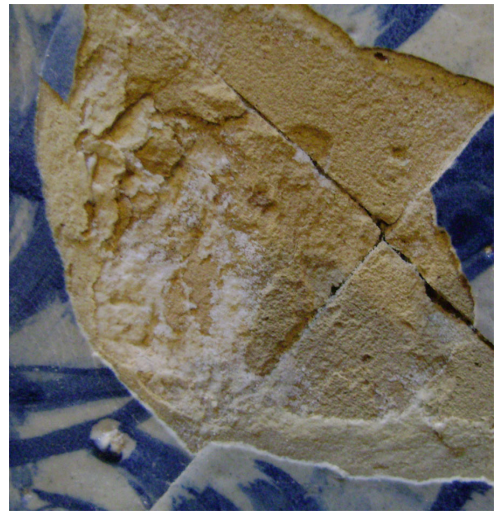
Figuras 10, 11- Danos de cristalização no corpo dos azulejos, sendo visíveis eflorações
