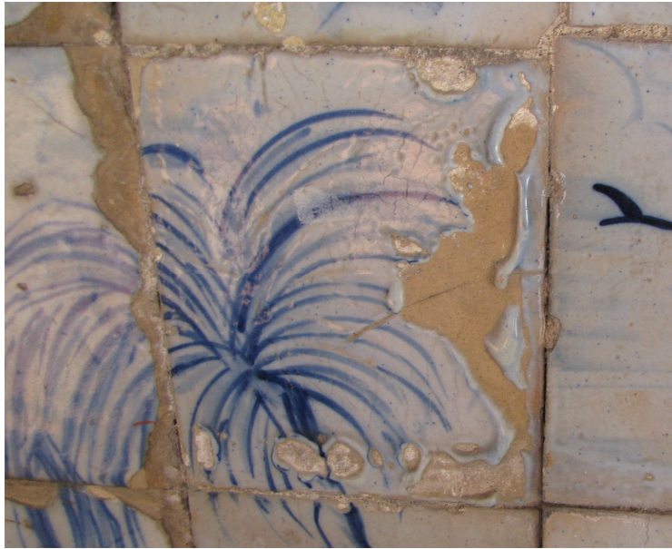
Figura 22- Nota-se, neste azulejo, diversas marcas de enrolamento o que significa que a chacota esteve exposta desde a fabricação. Nas áreas de menores dimensões, reconhecem-se eflorescências. No entanto a área maior está livre de eflorescências e em nenhum local houve queda do vidrado.
