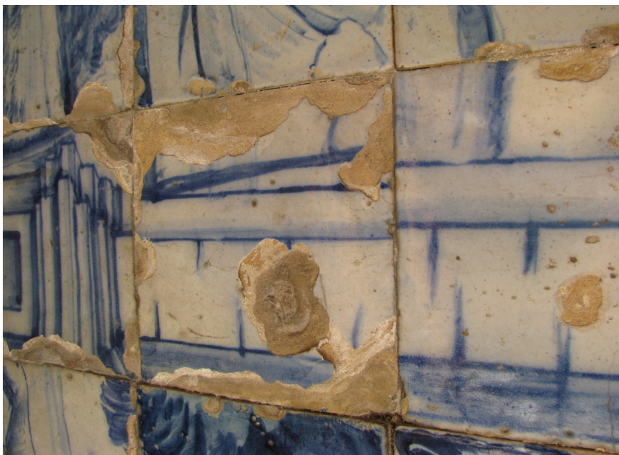
Figura 19- Imagem ilustrativa da situação: notam-se zonas de perda periféricas, seguindo as arestas, e zonas centrais aproximadamente circulares.
