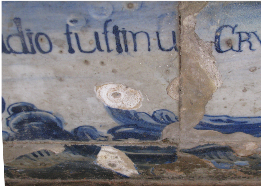
Figura 20- Note-se os sinais de cristalização nas lacunas centrais, bem como a marca que denota a posição do poro através do qual a humidade do suporte se deve ter evaporado. Note-se, também, a existência doutros poros no vidrado, alguns dos quais já com uma auréola que pode ser indício de um processo de degradação nascente.
